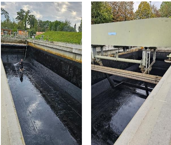
Vidange et nettoyage des décanteurs
